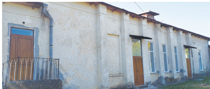
Окна, двери в ДК заменены, предстоит комплекс ремонтных работ, включая фасадные
